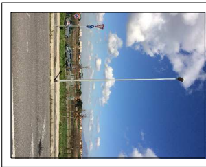
Foto palo in acciaio con singola armatura per illuminazione stradale (1 x 250 W S.A.P.)
