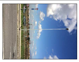
Foto palo in acciaio con singola armatura per illuminazione stradale (1 x 250 W S.A.P.)
